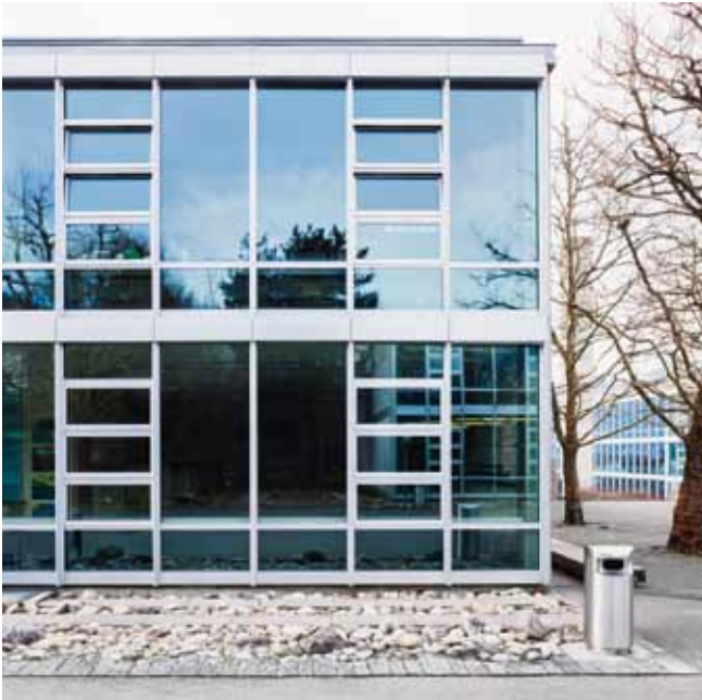
Fassadensanierung Säli-Schulhaus, Olten Bauherrschaft: Einwohnergemeinde Olten, Olten Architektur: werki Architekten und Planer AG, Olten
